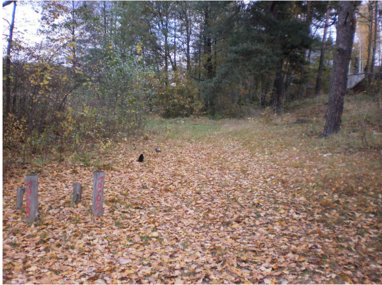
Fot.3. Zdjęcie drogi (ul. Witosa) od strony południowej – widok od ul. Wierzejskiej. Widoczne przerwanie ciągłości drogi, wskutek zalania wodami i zarośnięcia strefy brzegowej.
